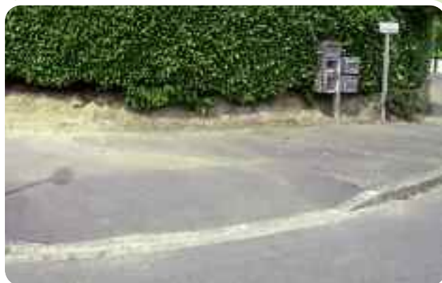
Les trottoirs ont été abaissés dans plusieurs rues dont la rue de la Prée
