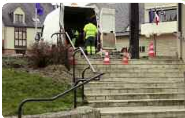
Remise en état de la main courante de l'escalier d'accès à l'esplanade de l'Hôtel de Ville
