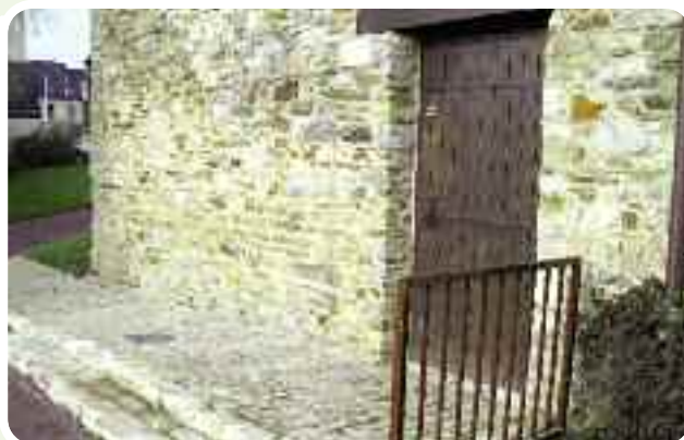
Une rampe d'accès permet désormais d'accéder facilement à l'Eglise
